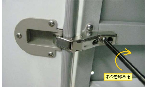
「前後調整ネジ」を(+)ドライバーで締めて、丁番を固定します。
