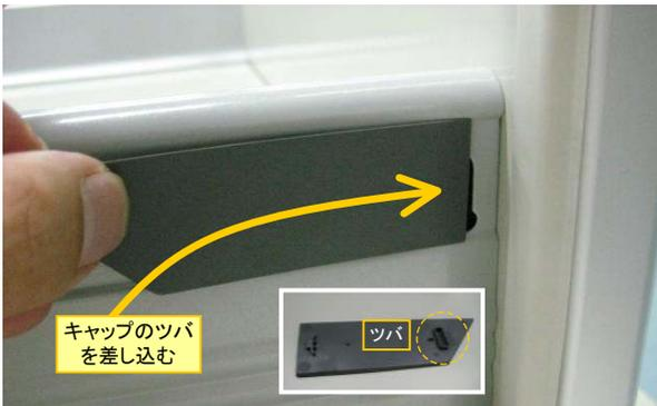
キャップ裏面のツバを調整ネジの穴に差し込みます。
