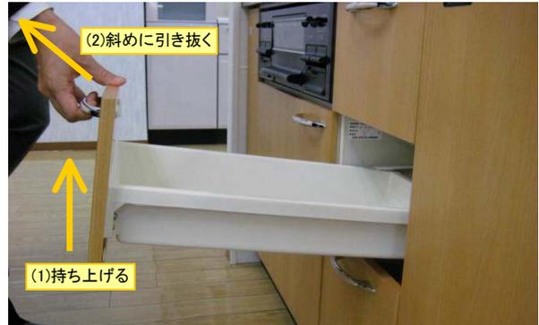
目一杯引き出した状態で、ゆっくり引出を持ち上げます。そのまま斜めに引き抜きます。
